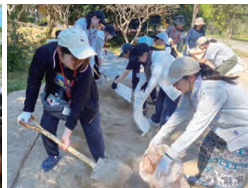
堤防のために土のうを作りました
